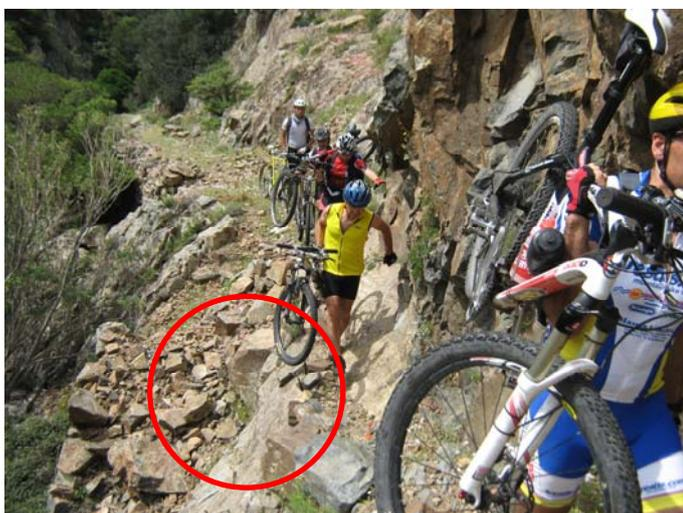
Tratti di percorso in cui necessita il ripristino dei muretti a secco di sostegno e la ricarica di materiale.
