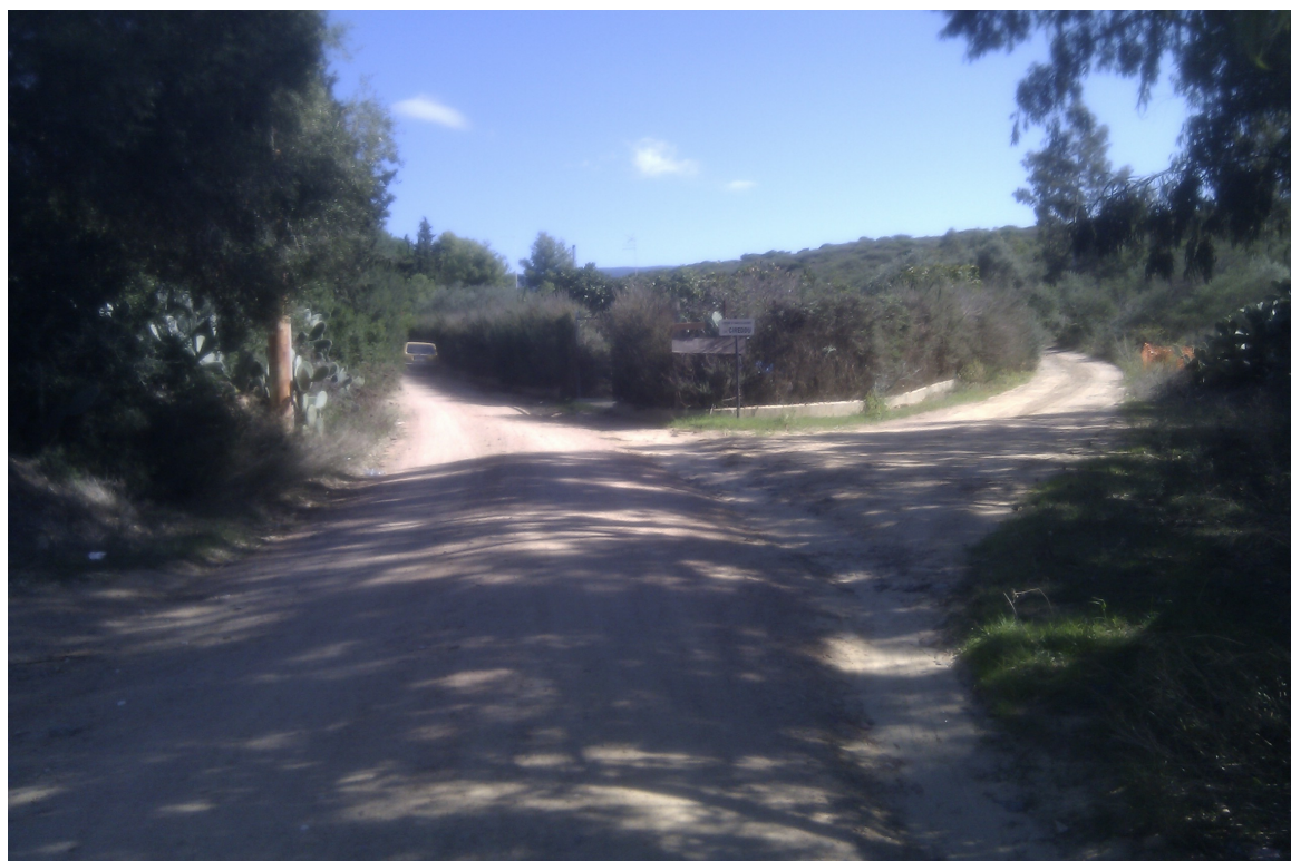
Figura 2. (F2) Incrocio con la strada consortile. È da notare la totale mancanza delle infrastrutture indispensabili per una sicura viabilità, che hanno portato al formarsi di un notevole fossato scavato dalle acque meteoriche che in questo punto possono raggiungere portate ragguardevoli
