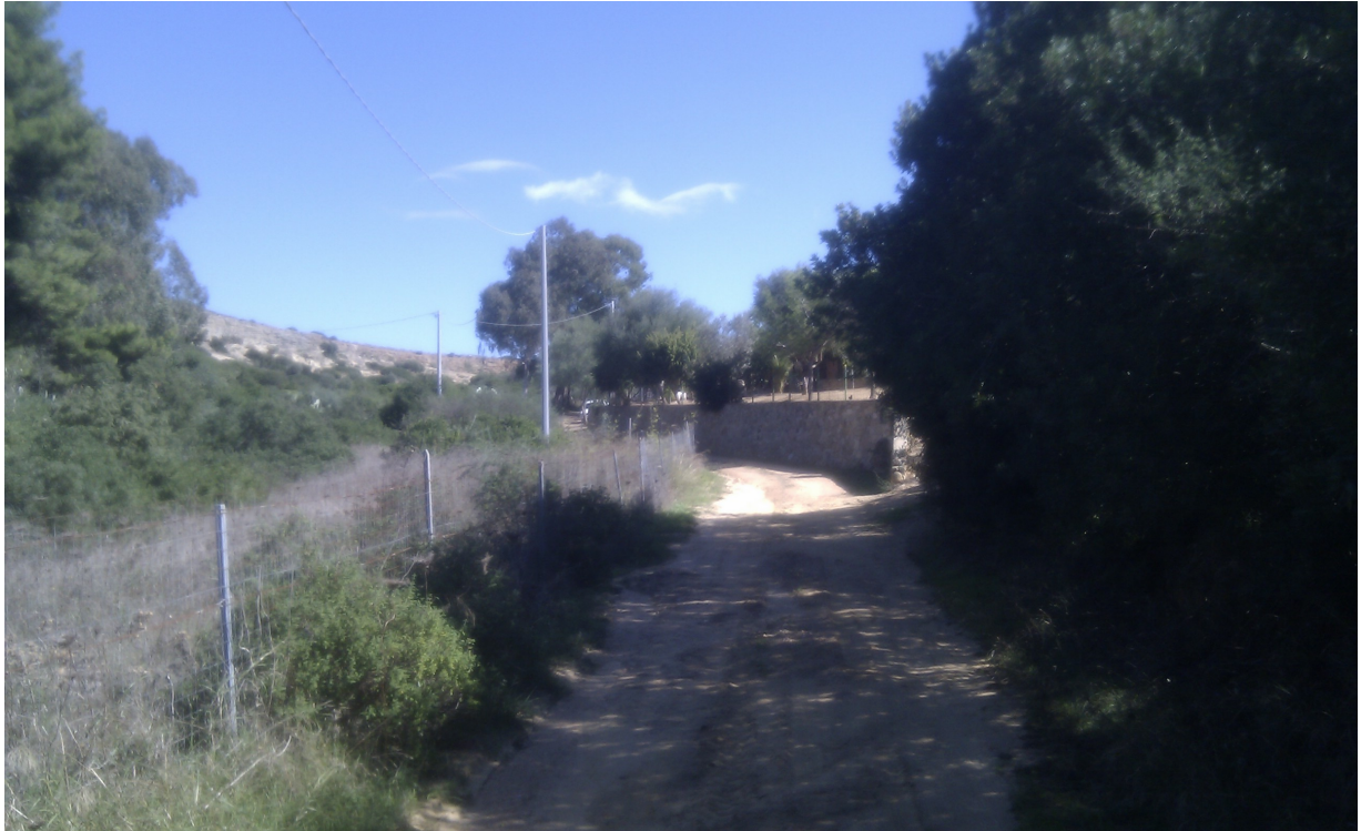
Figura 3. Tratto a larghezza ridotta (F3), caratterizzato dalla presenza di arbusti che, per brevi tratti, ingombrano la sede stradale, il fondo risulta essere notevolmente dissestato, sagomato dallo scorrere delle acque meteoriche.
