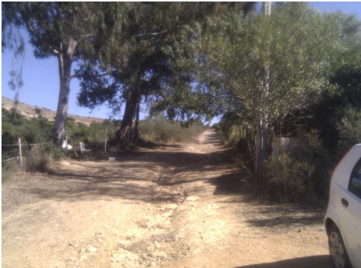
Figura 3. Tratto a larghezza ridotta (F3), caratterizzato dalla presenza di arbusti che, per brevi tratti, ingombrano la sede stradale, il fondo risulta essere notevolmente dissestato, sagomato dallo scorrere delle acque meteoriche.
