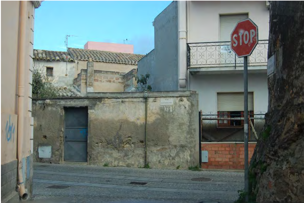
Foto 12. Tratto Urbano Sinnai, via Oristano incrocio con via Funtanalada: vista dello stato di attuale dei luoghi. Punto di ripresa F12 indicato nella Tav.6.
