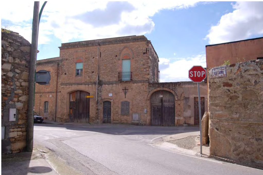
Foto 3. Tratto Urbano Settimo San Pietro, via Roma incrocio con via Deiana: vista dello stato di attuale dei luoghi. Punto di ripresa F3 indicato nella Tav.4.
