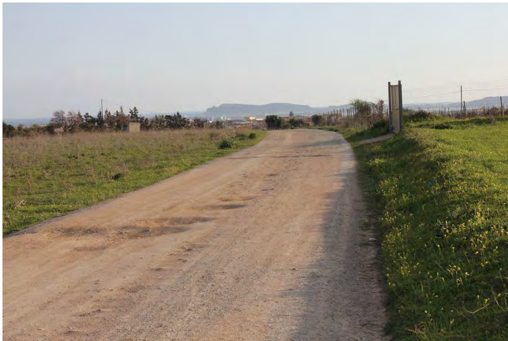
Foto 1. Tratto T1a:vista dello stato di attuale dei luoghi. Punto di ripresa F1 indicato nella Tav.4
