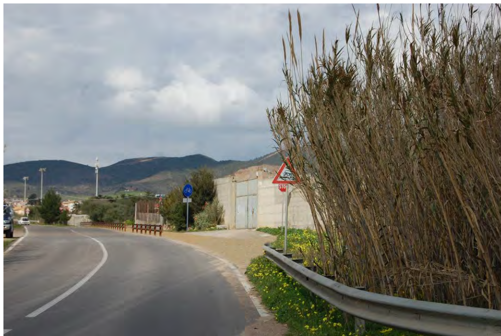
Simulazione 9. Simulazione fotografica della foto 9: p.to F9 Tav.6 Simulazione delle opere in progetto di pavimentazione in terra stabilizzata, posa di barriere di protezione e di segnaletica stradale verticale.
