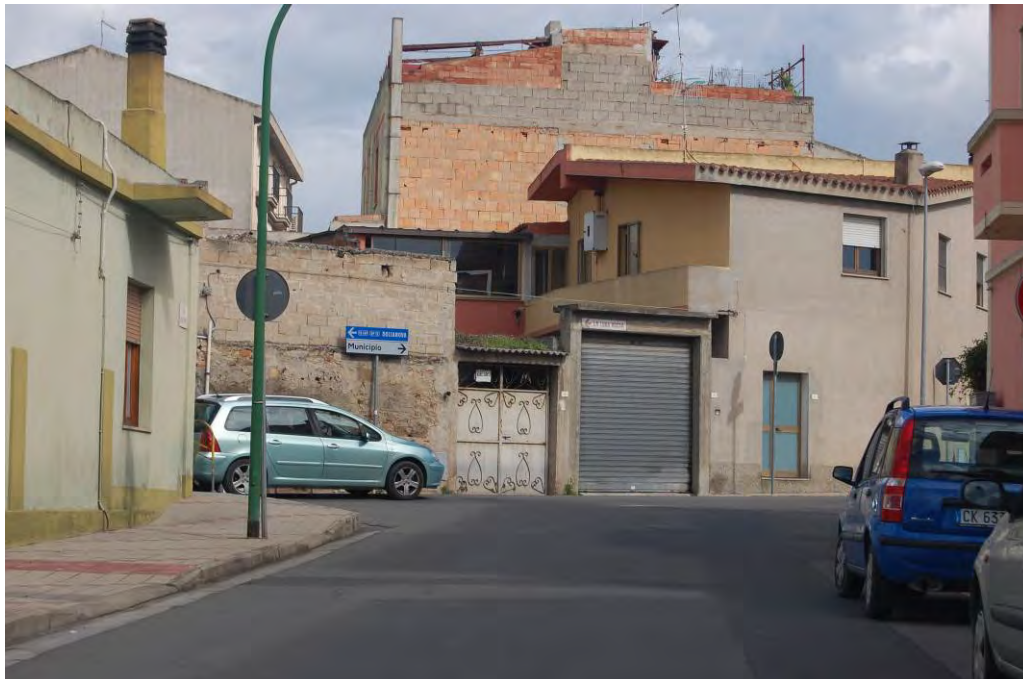
Foto 4. Tratto Urbano Settimo San Pietro, via Aldo Moro incrocio con via Stazione: vista dello stato di attuale dei luoghi. Punto di ripresa F4 indicato nella Tav 4.
