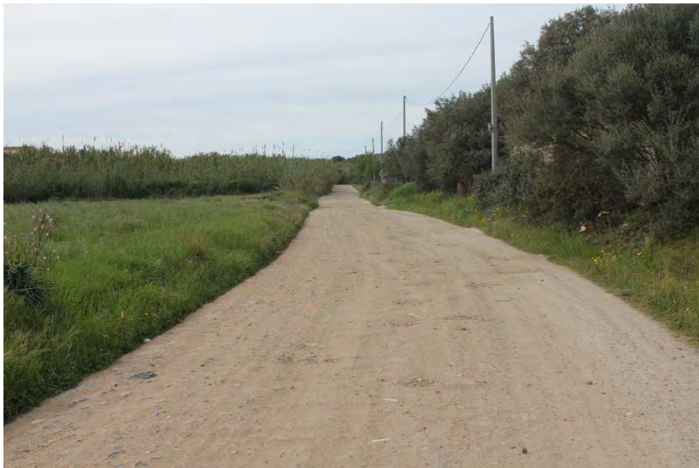
Foto 6. Tratto T2a:vista dello stato di attuale dei luoghi. Punto di ripresa F6 indicato nella Tav.6
