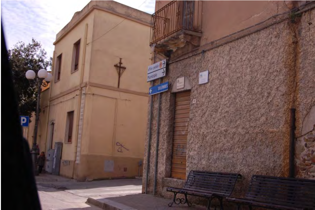
Foto 2. Tratto Urbano Settimo San Pietro, via Gramsci: vista dello stato di attuale dei luoghi. Punto di ripresa F2 indicato nella Tav.4
