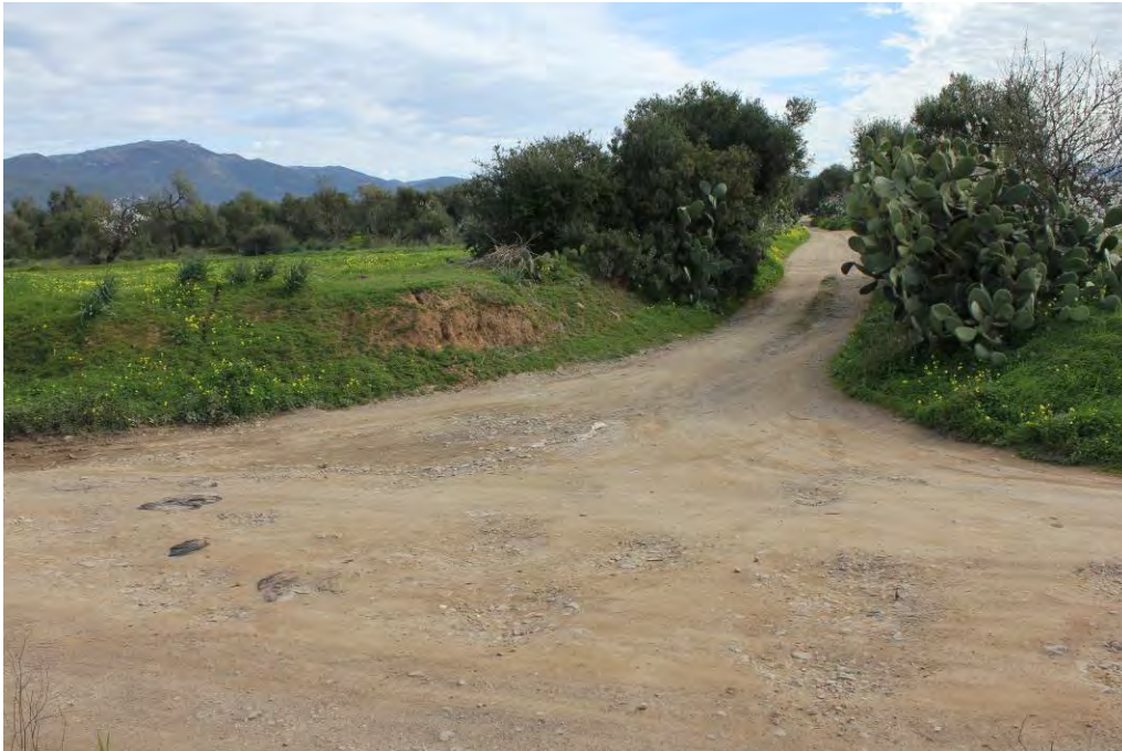
Foto 7. Tratto T2a: vista dello stato di attuale dei luoghi. Punto di ripresa F7 indicato nella Tav.6.
